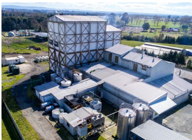
Planta de nuestra Filial Lácteos & Energía que ha abierto su portafolio de productos, vinculando el servicio de secado de leche en su matriz de servicios.
