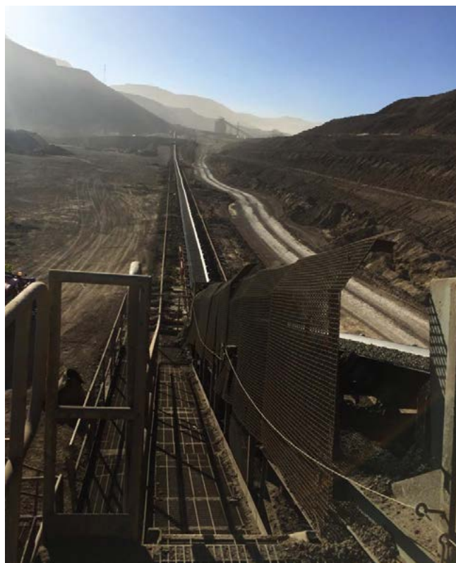
Correa transportadora en faena Manto Verde de Mantos Copper
