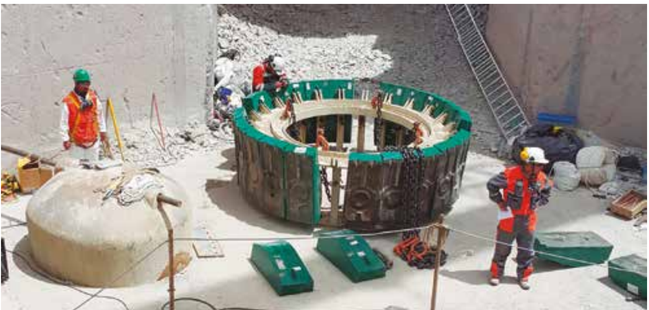
Faena de mantenimiento de planta minera en la División Radomiro Tomic, de Codelco (Schwager Service).
